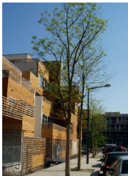
Chantier réalisé à Lille
