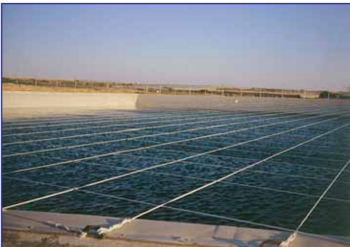
Grâce à sa légèreté, sa résistance, sa tension et une surface de contact lisse, le DELTEX® est utilisé pour la couverture des bassins, pour les filets paragrêles et coupe-vent ainsi que pour la construction de serres.
